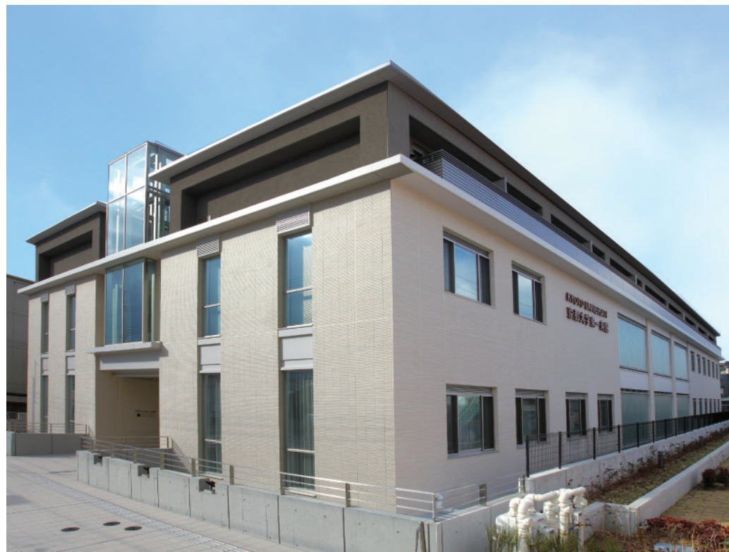
3階には第三研修施設もある思修館
